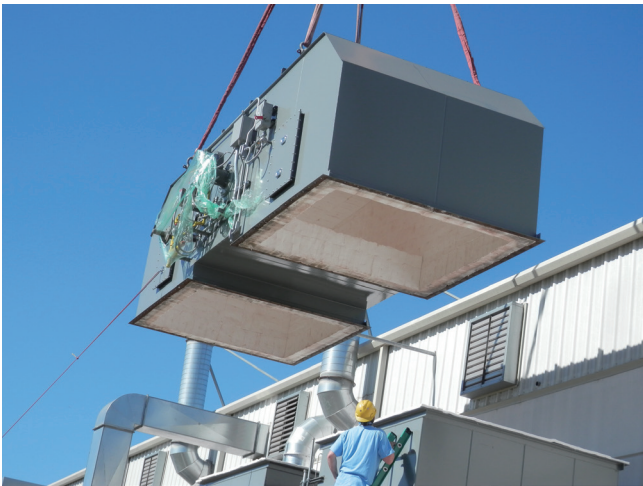
图 3 ❖ 正在安装的再生式热氧化炉，显示了交替热回收循环中使用的两个陶瓷介质衬里床。
