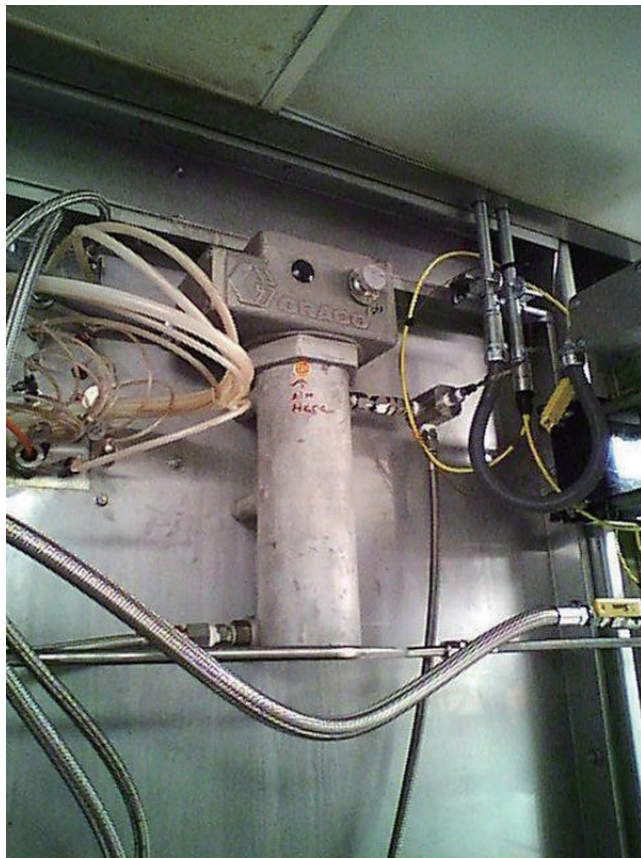
图6 ❖ 安装在喷漆室墙壁外侧的直列加热器。 5
