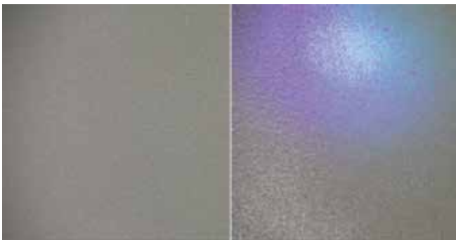
图5 ❖ 带荧光底涂的覆盖不足的灰色环氧面漆。
