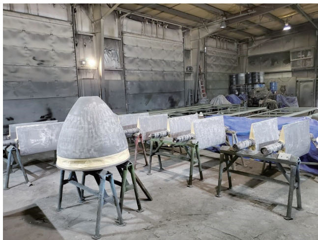
Belzona 1111 (Super Metal) 应用表面预处理期间的水电机组。
