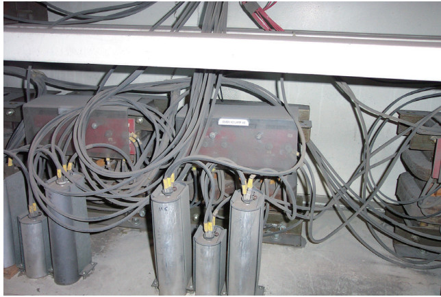
图4 ❖ 多尘的内部电源组件。
