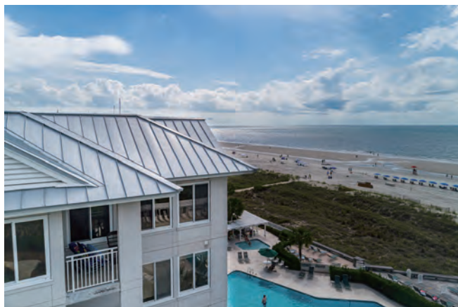
由杜邦Tedlar PVF薄膜保护的南卡罗来纳州一家海滨酒店的铝屋顶。
